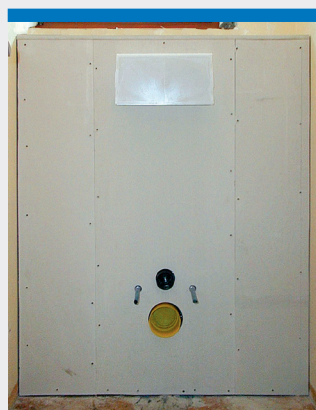
Beplankt mit Gipsfaserplatten
