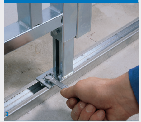
3 An Bodenschiene fixieren.
