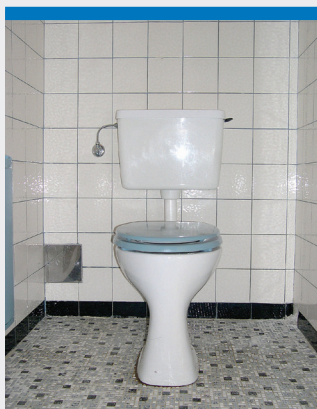
Alte WC Anlage
