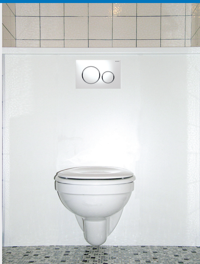
Fertig beplankte WC-Anlage
