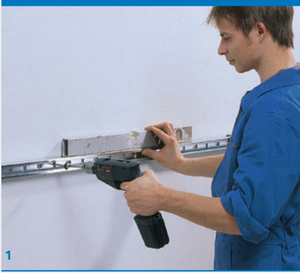
1 Montageschiene montieren.
