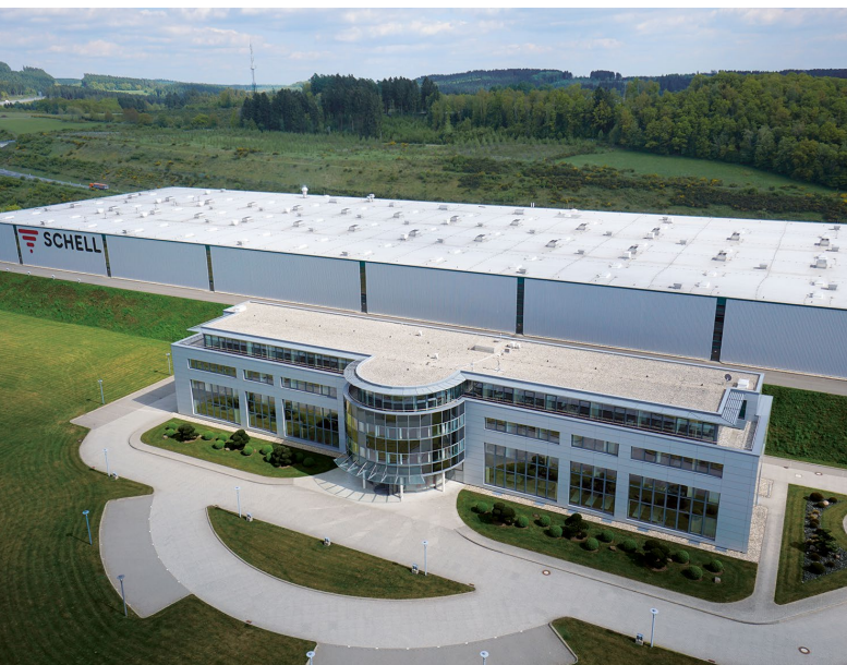
Werk 1 Produktion mit Verwaltungsgebäude und Schulungszentrum
