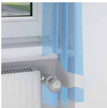
falsch Der Thermostat-Kopf mit eingebautem Fühler darf nicht von Vorhängen verdeckt werden.
