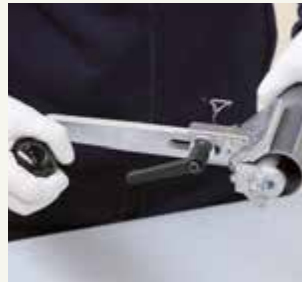
2. Rohrenden mittels eines Rohr-anschrägerätes oder einer Feile anschrägen.
