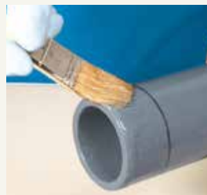
11. Das Rohrende ebenfalls axial unter kräftigem Pinseldruck satt einstreichen.
