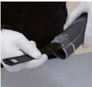
9. Das Rohrende ebenfalls axial unter kräftigem Pinseldruck satt einstreichen.
