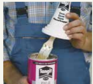
8. Um das Eintrocknen zu verhindern, Dosen in den Klebepausen mit der Tangit Pinselkappe verschließen.
