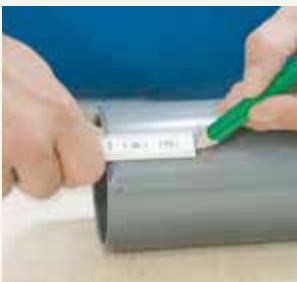
5. Das Maß auf dem Rohrende markieren.
