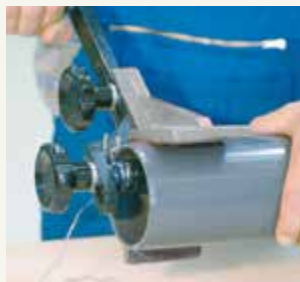
2. Rohrenden mittels eines Rohr-anschrägegerätes oder einer Feile anschrägen.
