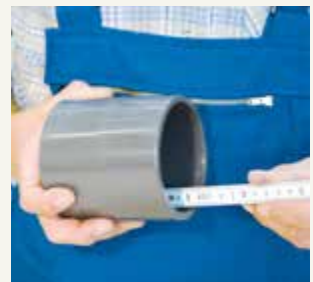
4. Die volle Rohreinstecktiefe ausmessen.
