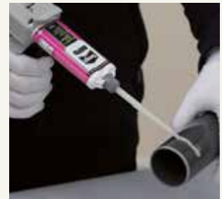
8. Klebstoff auf der Rohraußenseite auftragen.
