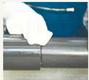
12. Rohr und Fitting sofort ohne Verdrehen bzw. Verkanten bis zur vollen Fittingtiefe zusammenschieben. Überschüssigen Klebstoff mit Fließpapier entfernen.
