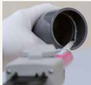
6. Klebstoff auf der Fittinginnenseite auftragen.
