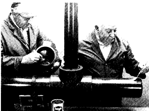
Bild 7: Klebstoffauftrag bei d \geq 110 mm
