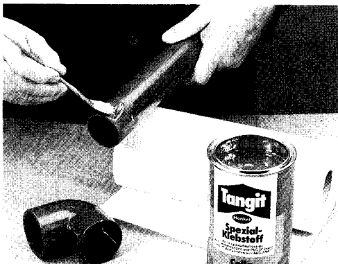
Bild 6: Klebstoffauftrag bei d \leq 90 mm
