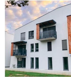
"Vila Blok Šubičeva": 25 Niedrigenergie-Luxusapartments in Maribor (Slowenien)
