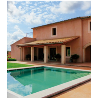
Sanierte Premium Passivvilla „Proyecto Tierra“ in Lluçmajor, Mallorca (Spanien)
