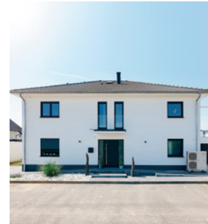
Villa in einer neuen Wohnsiedlung in Bruchköbel (Deutschland)
