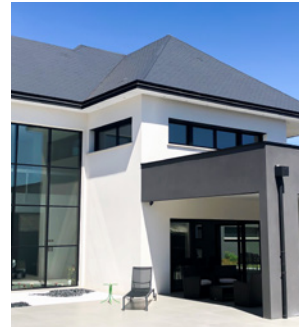
610m 2 großes Haus mit Fußbodenheizung und Warmwassererzeugung in Saint-Prest (Frankreich)
