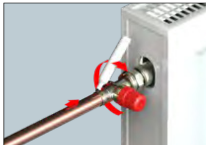
Danach wird das Rohr in die Pressmuffe des Ventils eingeführt und die Einstecktiefe mit einem Stift markiert, um sicherzustellen, dass das Rohr nach dem Pressvorgang richtig sitzt.
