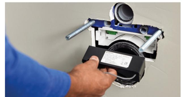
Installation des GEBUS-Konverters für WC-Steuerungen mit integriertem Netzteil
