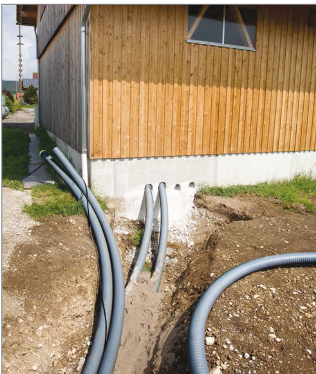
Abb. 115: Montagebeispiel Stützhülse und Kompaktdichtung
