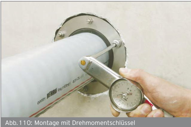
Abb. 110: Montage mit Drehmomentschlüssel
