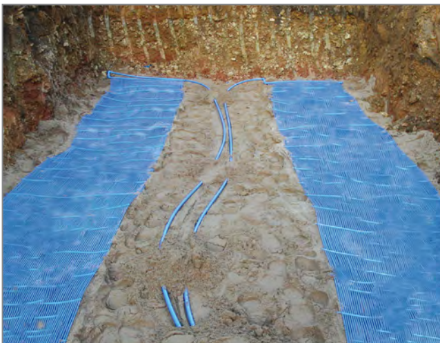
Abb. 75: Verlegung des Kompaktkollektors
