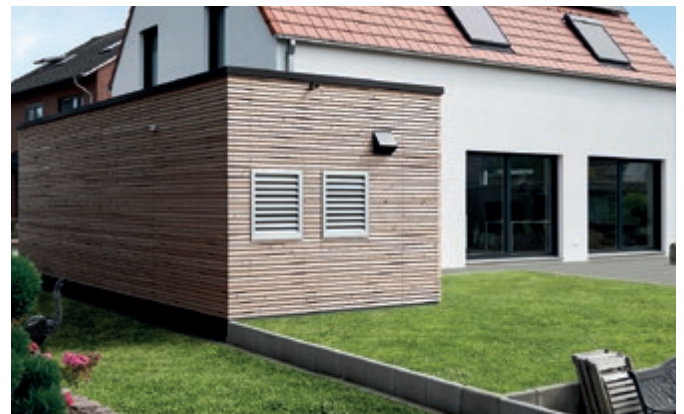
Luftgitter für die Wärmepumpe im Außenbereich
