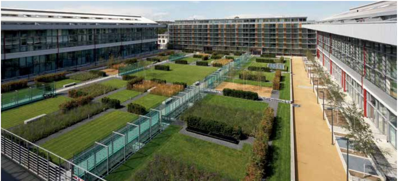
London (Großbritannien): Mehrfamilienhäuser mit Heizung und TWW-Bereitung im Durchflussprinzip
