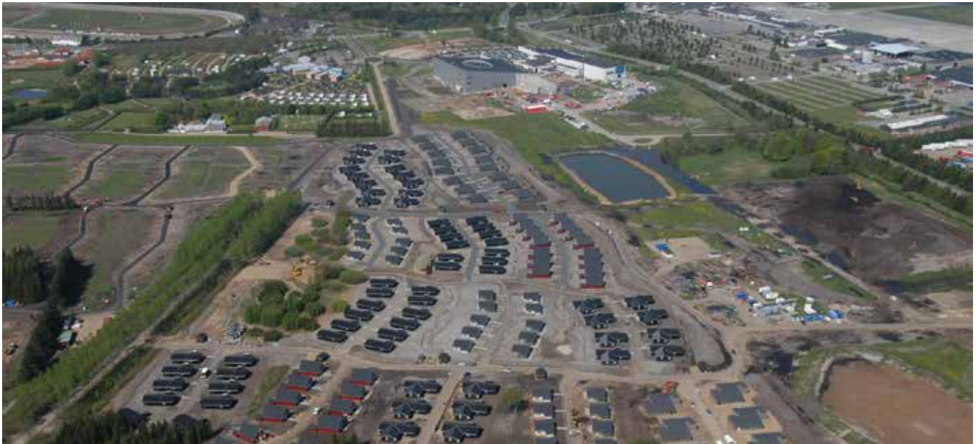
Billund (Dänemark) – Einfamilienhäuser mit Fernwärmeversorgung
