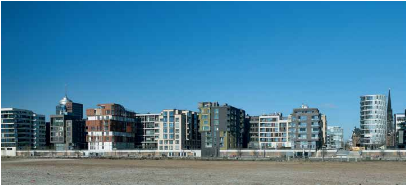
Hamburg (Deutschland) – Mehrfamilienhäuser und Gewerbebauten mit Heizung und TWW-Bereitung im Durchflussprinzip
