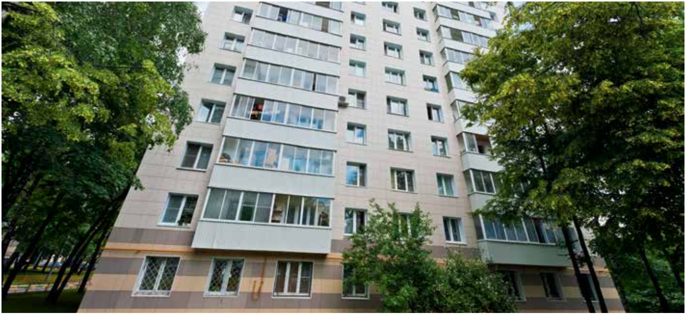
Moskau (Russland) – Mehrfamilienhäuser mit Fernwärme-Applikation
