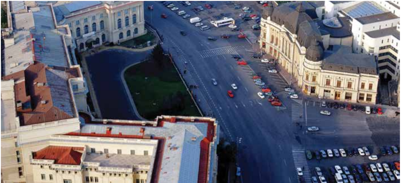
Bukarest (Rumänien) – Mehrfamilienhäuser und Gewerbebauten mit Fernwärmeversorgung
