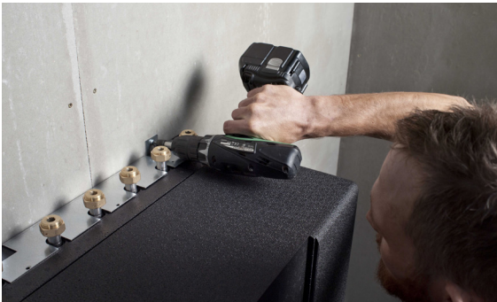
Die Station wird einfach an der Wand montiert. Mindestens zwei Personen werden für die Montage empfohlen. Hinweis: Niemals die Station an ihrer Frontabdeckung anheben!
